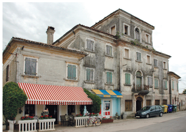
6. Sjeverno pročelje (Fototeka HRZ-a) North façade
