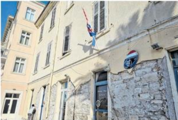
Počela obnova zgrade Lučke kapetanije na porečkoj rivi
